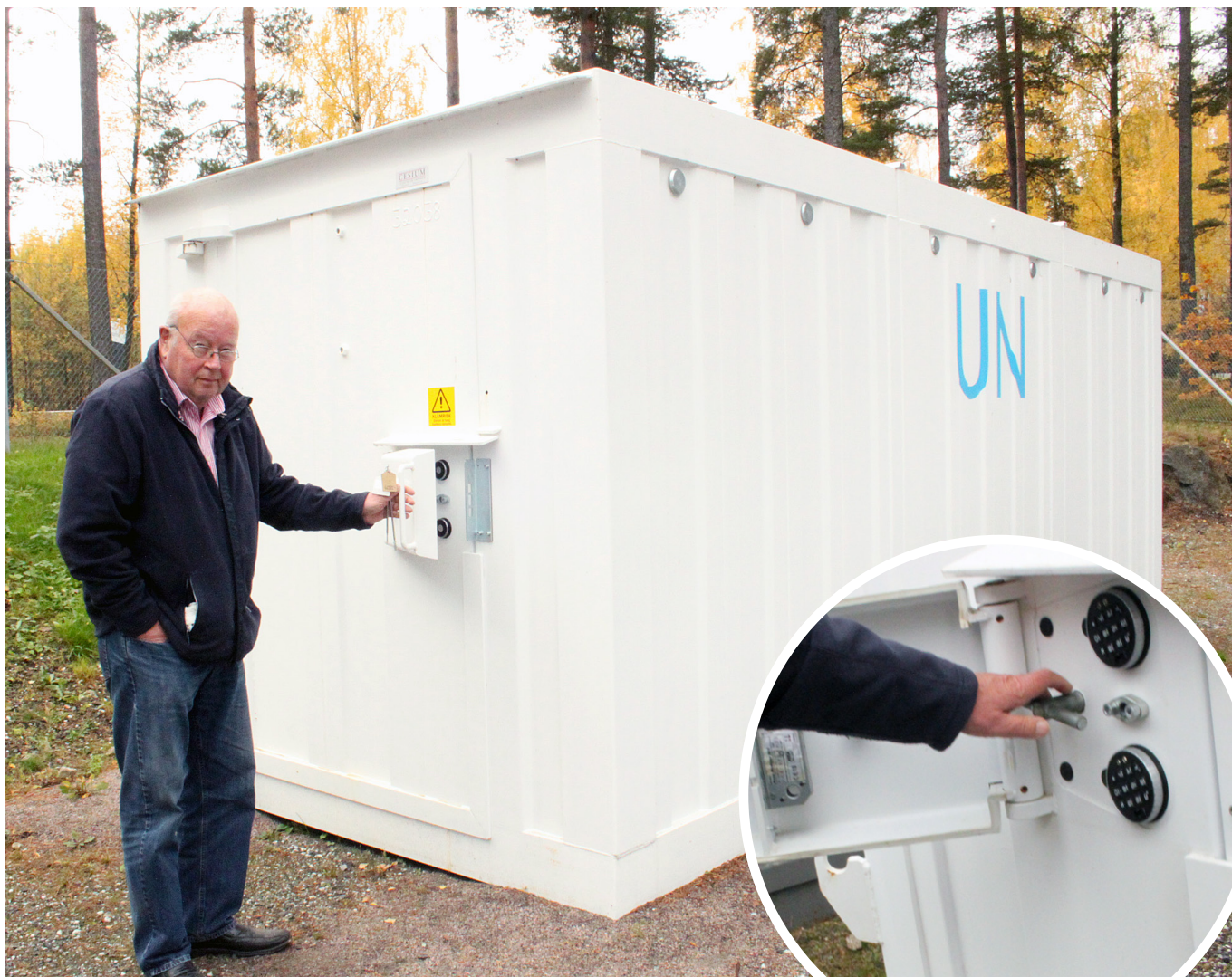
Säkerhetsförrådet på bilden väger 30 ton. Bara dörren väger 1,5 ton och är försedd med lås som gör det mycket svårt att ta sig in i förrådet.
